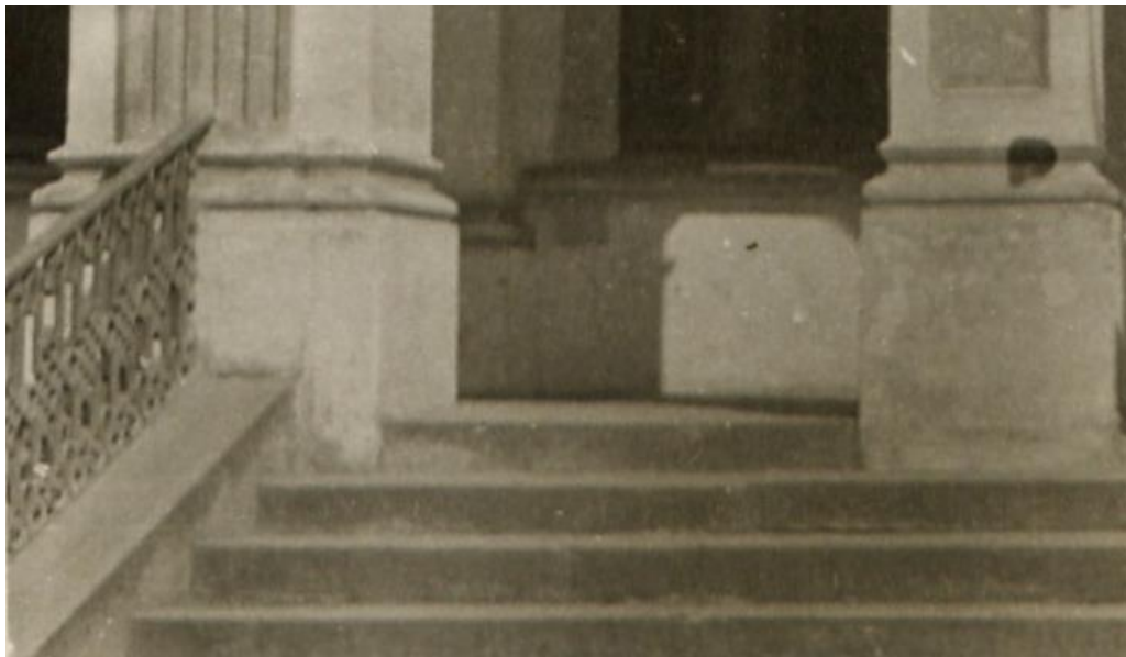
Zdj. 17 schody nr 1 lata 70-te XX w.- Schody na gruncie z bloków piaskowcowych- widoczny niższy poziom schodów.
